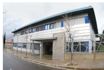
Façana de l'edifici on està ubicada la companyia Aigües de Mataró. Foto: ARXIU.
